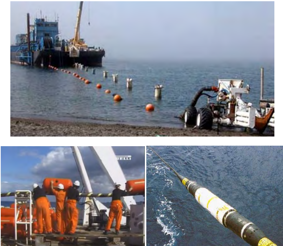
Figura No. 9.36 Parte inicial del tendido submarino del cable óptico.
