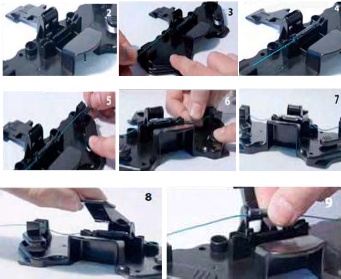
Figura No. 8.39 Pasos básicos en un proceso de empalme mecánico de fibras ópticas.
