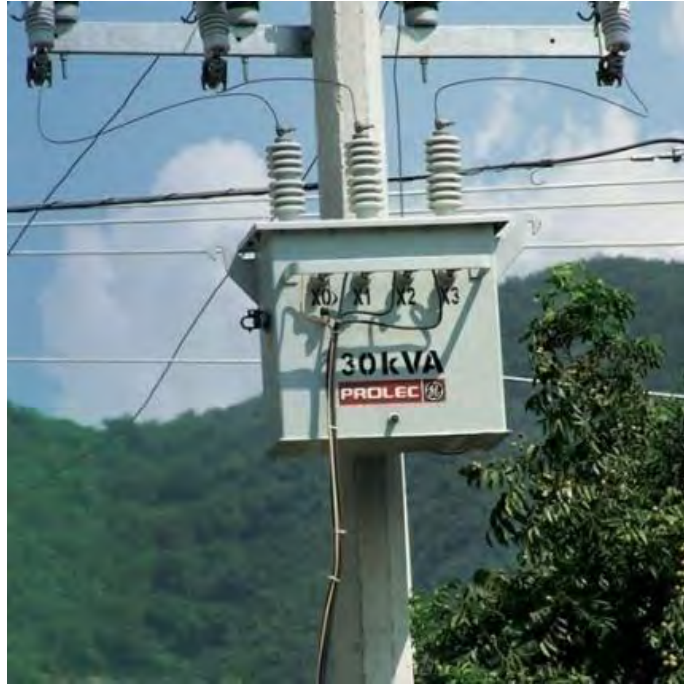
Figura No. 3.49 Transformadores de montaje tipo poste. Fuente: Catálogo "Transformadores tipo poste", Prolec General Electric, 2018.
