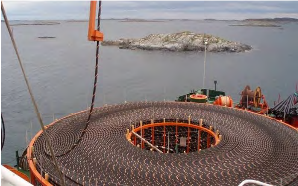
Figura No.9.34 Colocación del cable submarino en plataforma del barco cablero.
