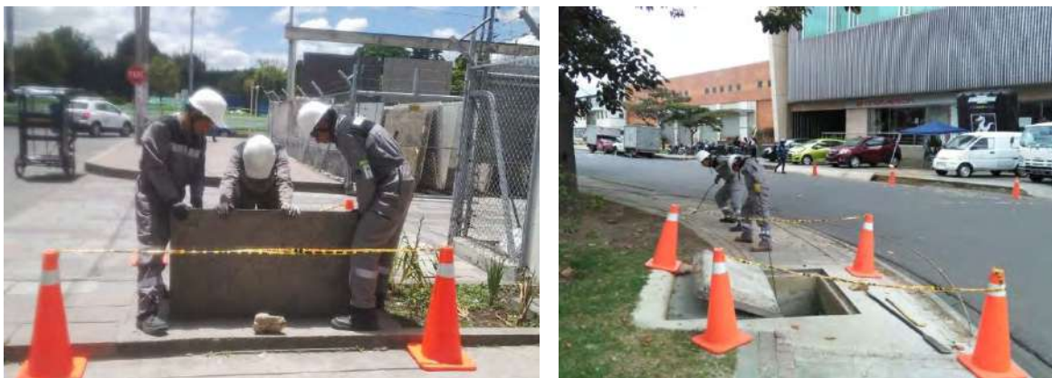
Figura No. 9.12 Proceso de jaloneo por fuera de la caja de empalme en tendido subterráneo manual.
