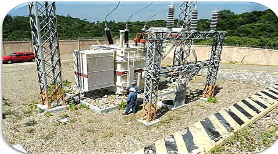
c.) Malla instalada
