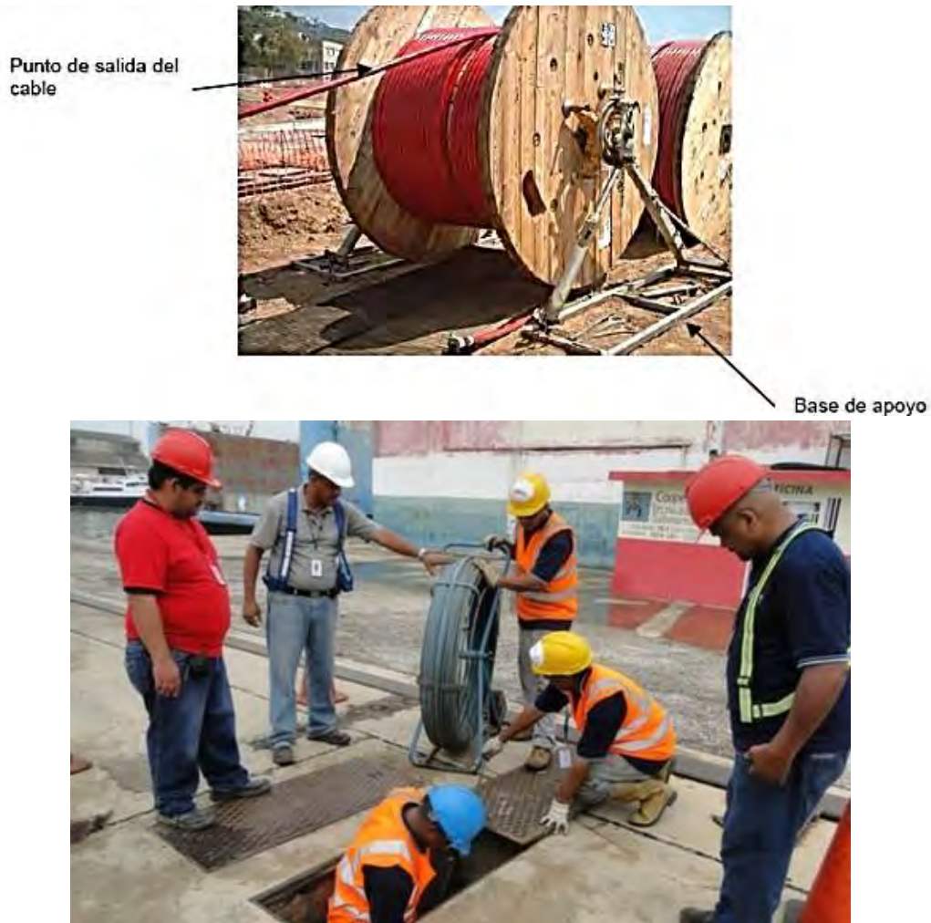
Figura No. 9.17 Posicionamiento de los carretes de cable óptico.
