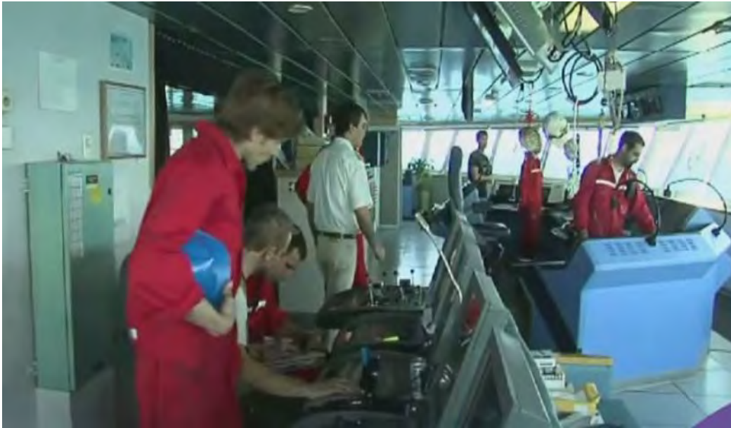
Figura No.9.40 Central de monitoreo y control del proceso de tendido de un cable submarino. Instalación de los flotadores en el cable submarino: tendido en el lecho marítimo del mismo.
