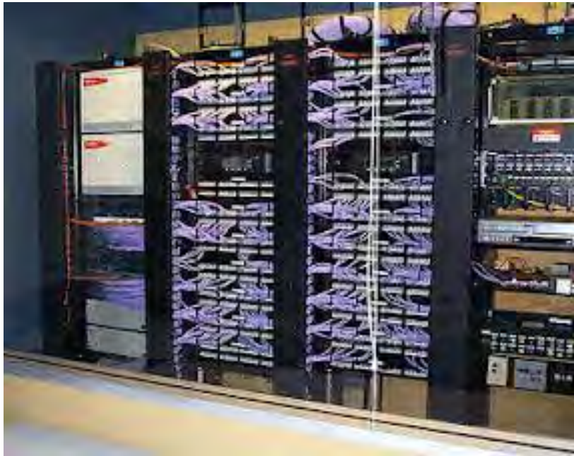
Figura No. 4.20 Imagen de un terminal MDF
