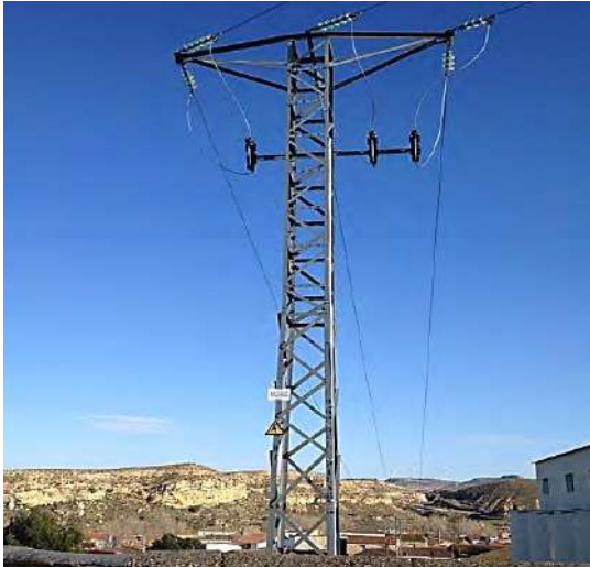
Figura No. 3.4 Tipos de torres para el tendido de líneas de media tensión
