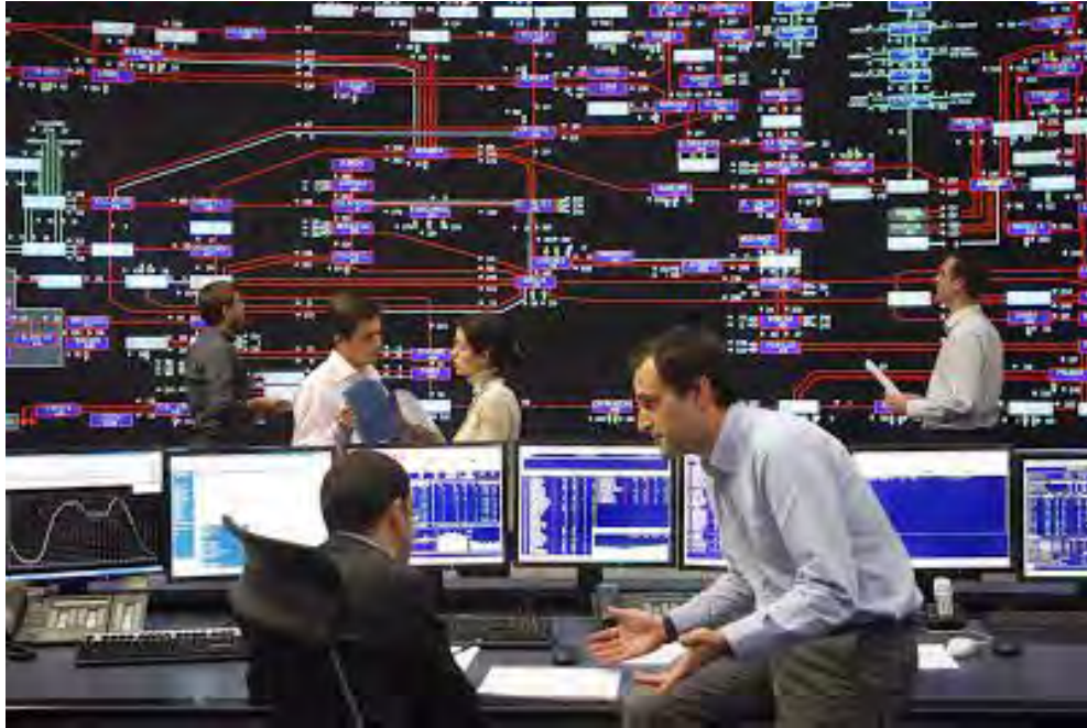
Figura No. 3.7 Central de visualización y control de una estación de transmisión de energía eléctrica.
