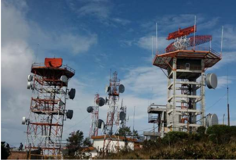
Ilustración 89 Estación Radar El Tablazo
